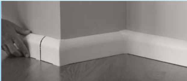
Stoßverbinder montieren
