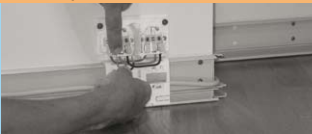
Kabel verlegen, abisolieren (18 mm), Kabel an Steckdosensockel einstecken (hierbei weiße Drucktasten an Federklemmen nach hinten drücken)
