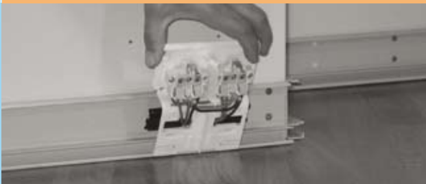
Unterteil unten in Wandprofil einschieben und an Wand drücken
