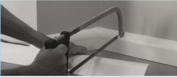
Deckprofil passend messen & ablängen
