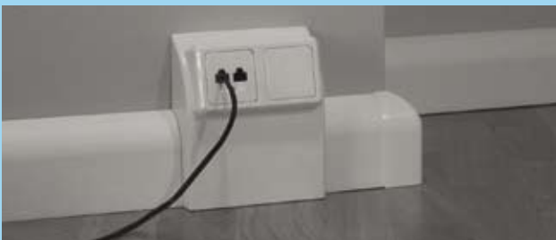
Äußeren Blendrahmen aufrasten, Sockelleiste fertigstellen FERTIG!
