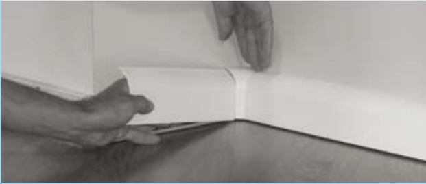
Innenecke montieren
