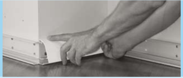
Deckprofil einhängen (erst oben, dann unten)
