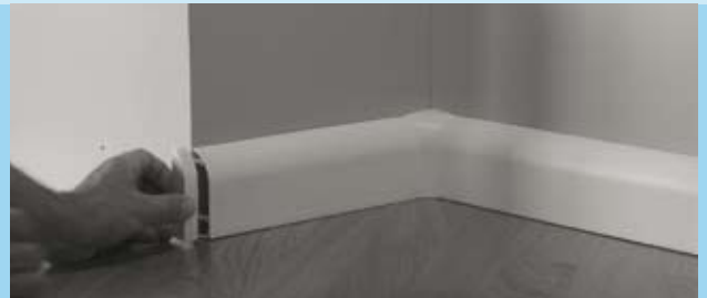
Endstück montieren - FERTIG!
