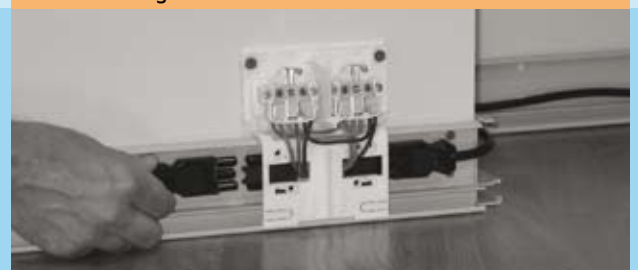
Steckverbindungen herstellen & Kabel verlegen
