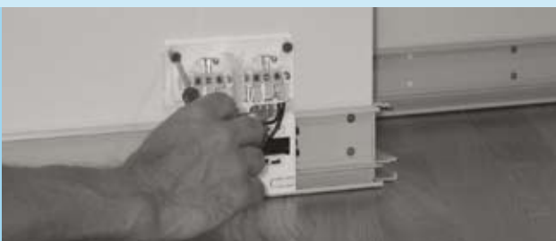
Dübel befestigen für Steckdosencontainer mit Kabelanschluss: weiter ab Bild 23 Bei Montage von Geräteeinsätzen für Daten, Telefon, Antenne: weiter ab Bild 25
