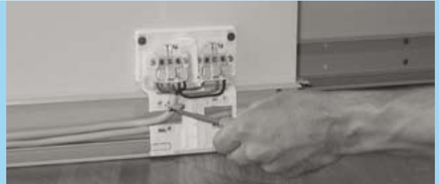
Zugentlastung aufschrauben weiter ab Bild 19 bis 22
