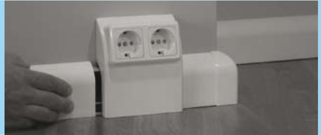
Sockelleiste ablängen und einschieben
